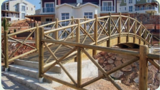
Ahşap Lamine Köprü 12 mt Güzelbahçe / İZMİR
