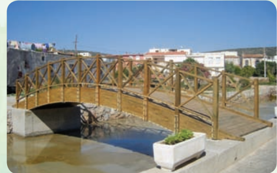
Ahşap Lamine Köprü 10 mt Çeşme / İZMİR
