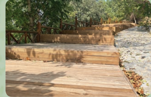
Ahşap Platformlu Merdiven Soma / MANİSA
