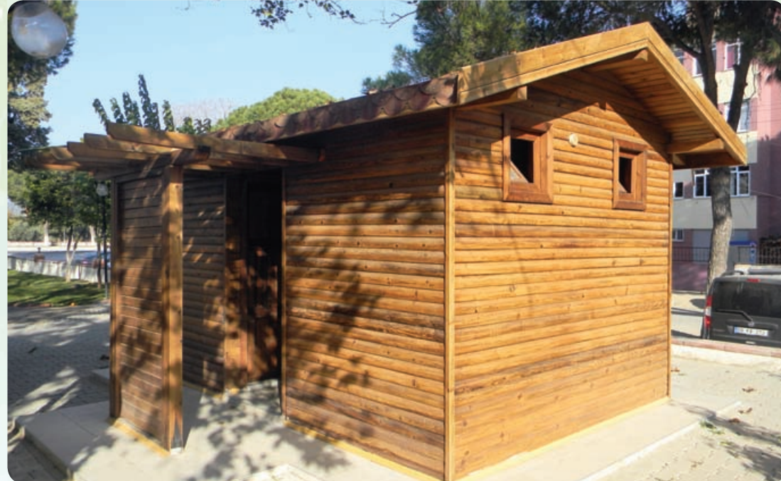
Ahşap Dörtlü WC
