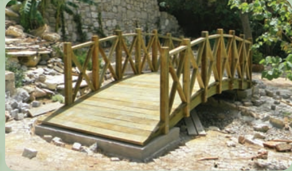
Ahşap Lamine Köprü 5 mt Çeşme / İZMİR
