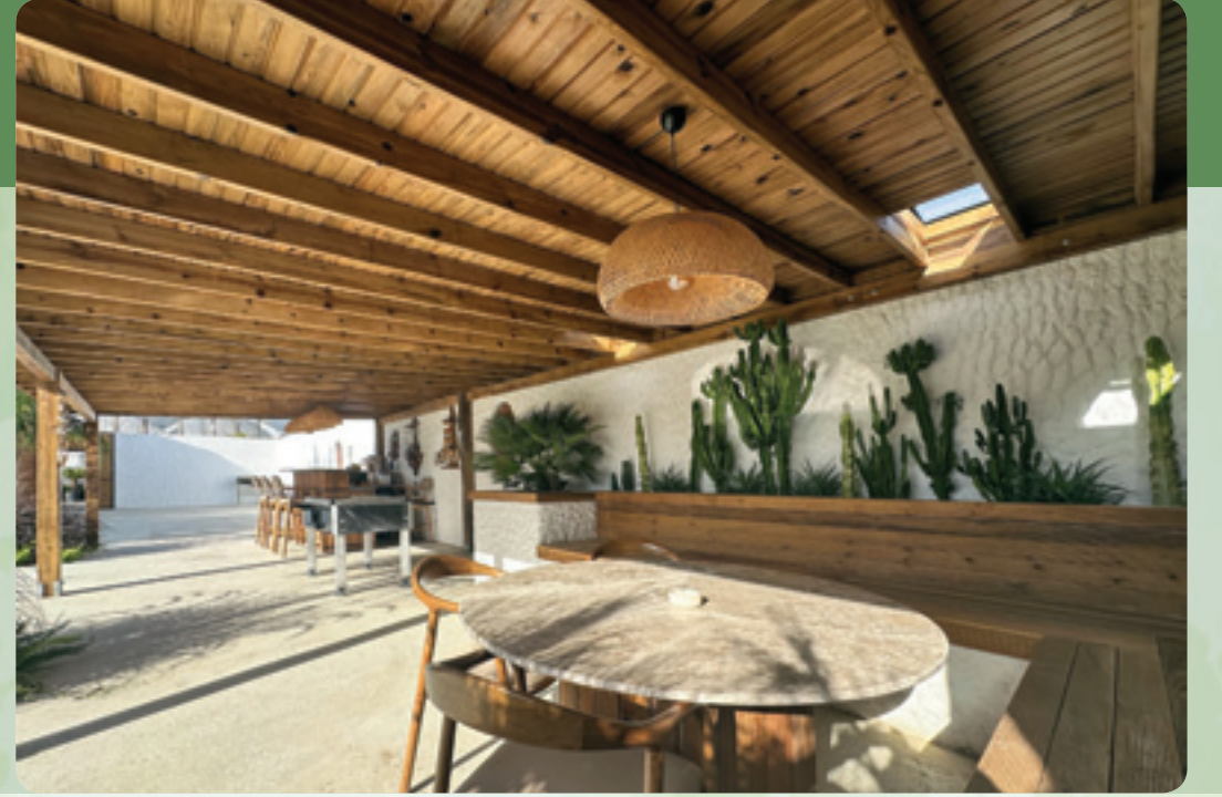
Ahşap Pergole ve Bar Uygulaması Bayındır / İZMİR
