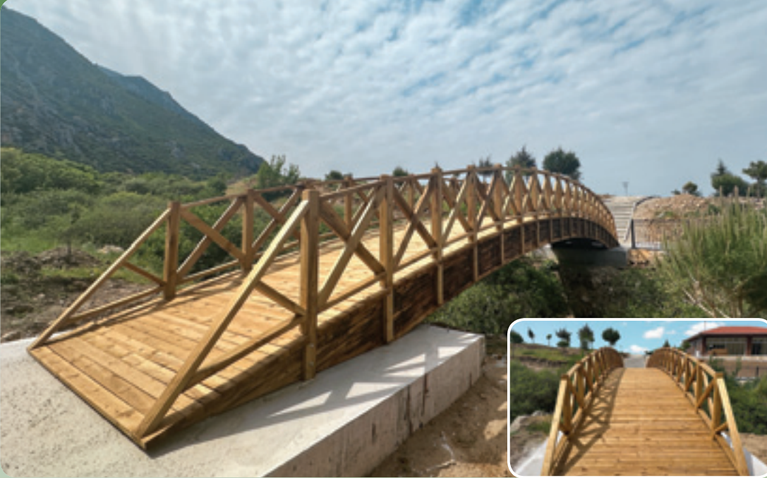
Ahşap Lamine Köprü 20 mt Şehzadeler / MANİSA
