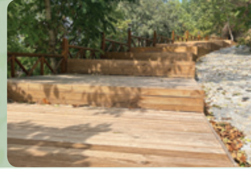
Ahşap Platformlu Merdiven Soma / MANİSA
