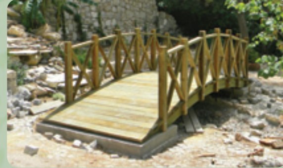
Ahşap Lamine Köprü 5 mt Çeşme / İZMİR
