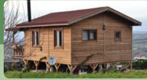
Ahşap Ev 42 + 18 m 2 Kuşadası / AYDIN
