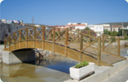
Ahşap Lamine Köprü 10 mt Çeşme / İZMİR
